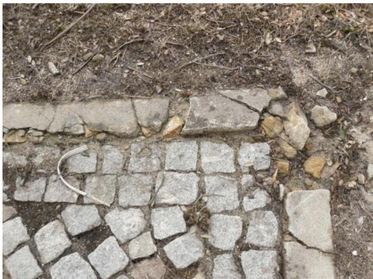
Fig.55-Pavimento em cubo de granito e lancil em alvenaria de pedra.
