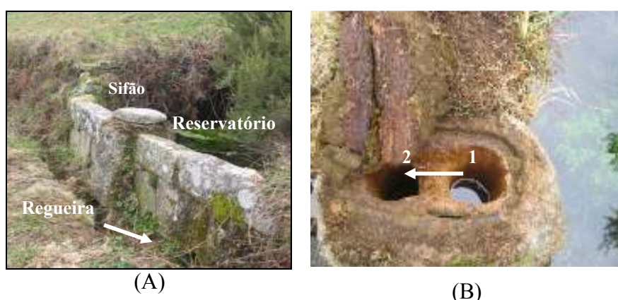
FIGURA 4 – (A) Sifão em pedra que estabelece comunicação entre o reservatório e a regueira; (B) detalhe do sifão, em que o fluxo de água se move do orifício 1 para o 2, em função da altura da água no reservatório, derivando um caudal de rega.
