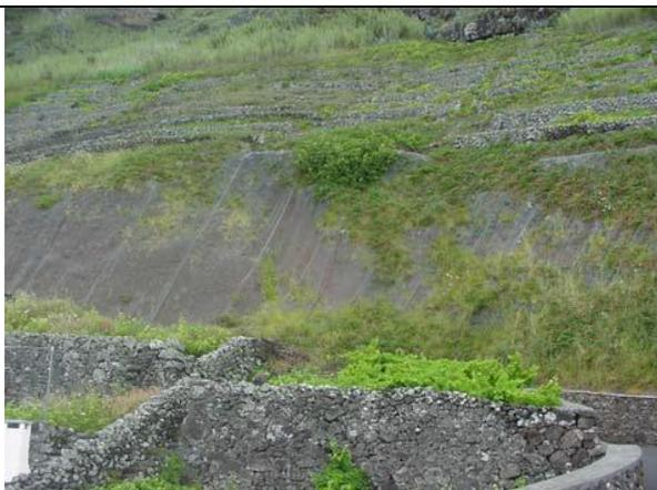
Baía da Maia. Proteção geotécnica do talude, com rede, para proteção da estrada (POOC Santa Maria)
